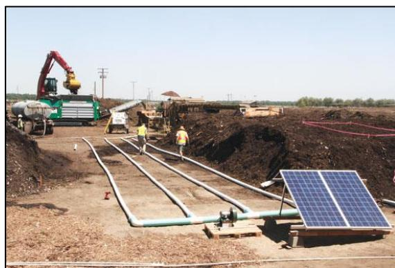
Slika 16 Korišćenje solarnih ploča za dobijanje energije potrebne za rad ventilatora
